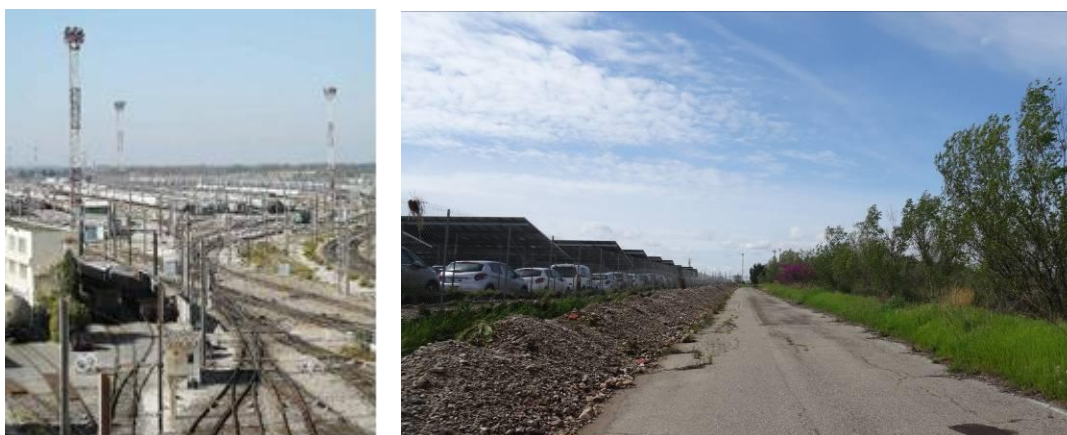
Figure 79 : Vue sur le faisceau de voies de garage (source : Google Earth) et vue sur les ombrières photovoltaïques avec la zone d'étude de l'autre côté de voie
