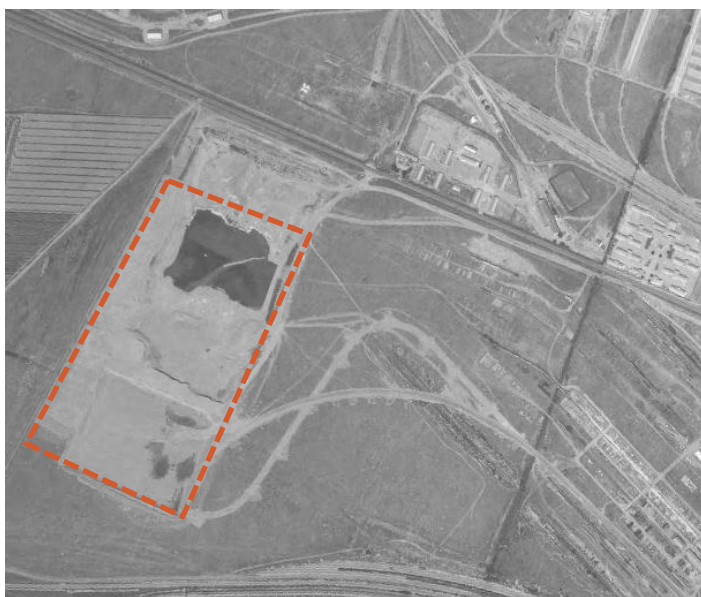
Figure 11 : Site d'étude avec zone d'extraction en 1977 (source : Géoportail - remonte le temps)
