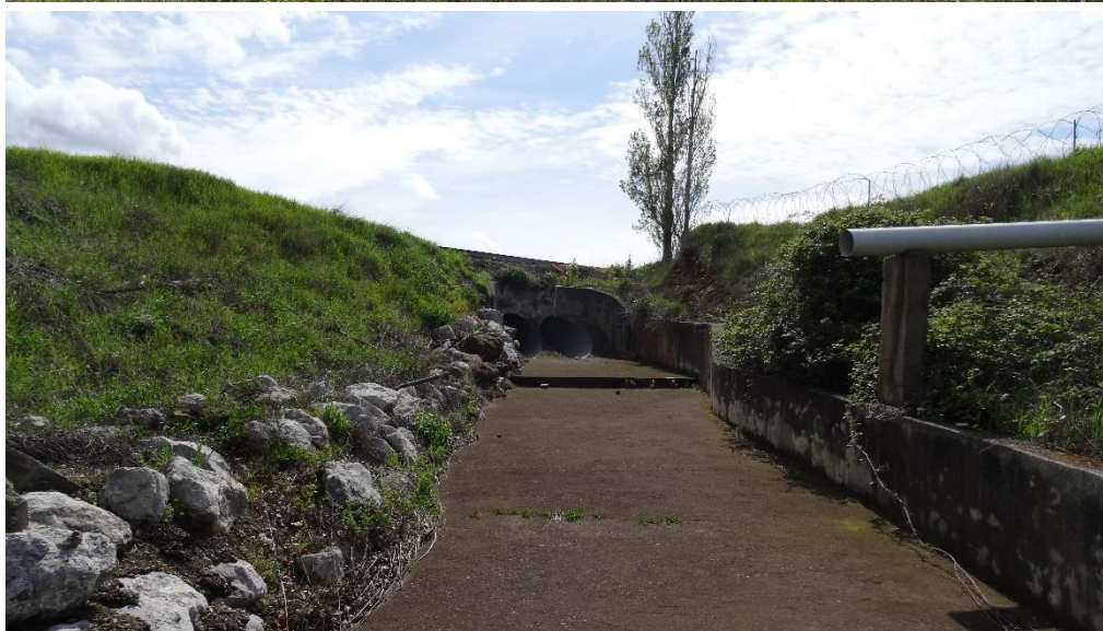
Figure 48 : Bassin de rétention et chenal d'évacuation localisés dans l'angle Sud-Est de la parcelle étudiée, photographies Biotope avril 2018
