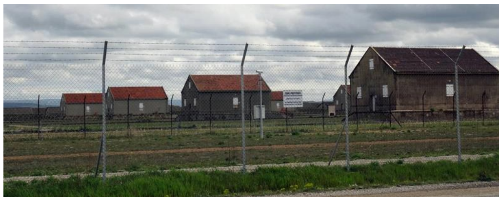
Figure 78 : Vue sur les igloos de stockage des munitions depuis la route RD10
